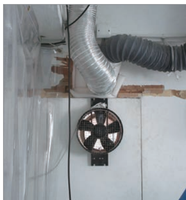
安裝抽風系統減低 室內空氣污染
