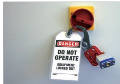
進行電力工程前掛上警告牌
