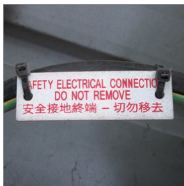
電源裝上合適接地
