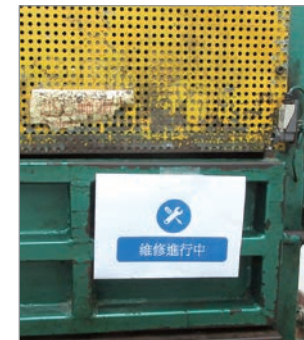
加上告示牌以示待修
