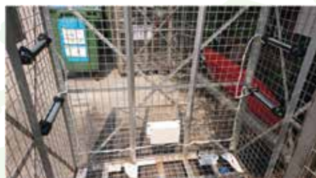
已安裝紅外線存量感應器的金屬籠
